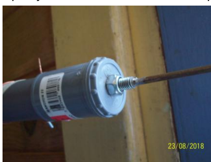
4- fixation du fouet télescopique
