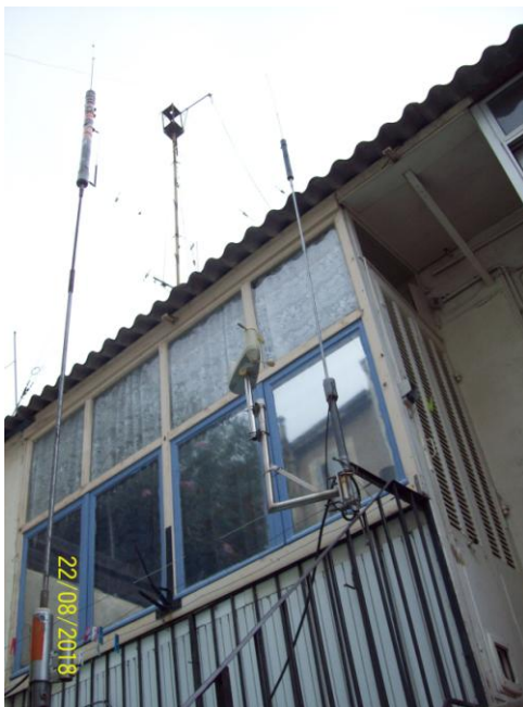
1- Excalibur à G et Durandal à D. En arrière plan, le mat qui supportait la beam et maintenant la G5rv
